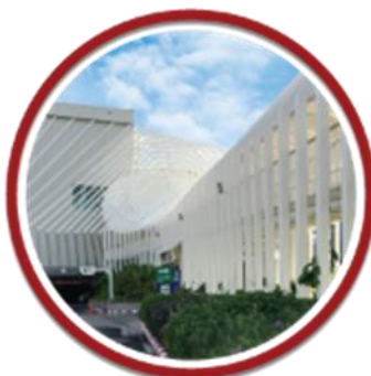
GENERAL CONSTRUCTION งานโครงสร้างทั่วไป
