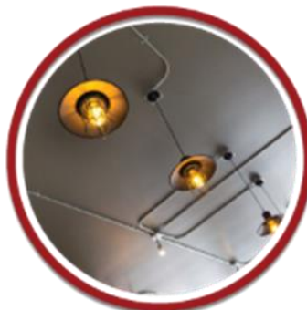
ELECTRICAL CONDUIT งานท่อร้อยสายไฟ
